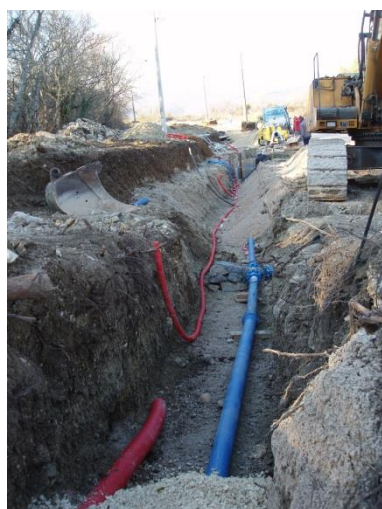
Izvršena rekonstrukcija vodovodnih cijevi unutar naselja Presika
