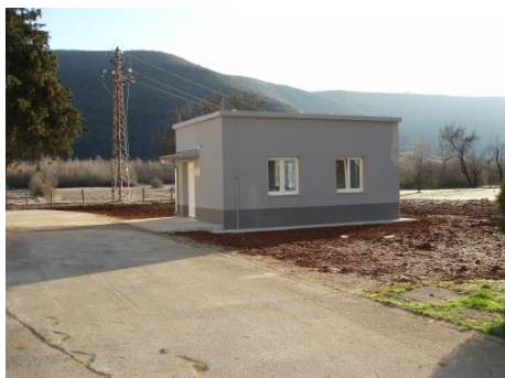
Izgradnja crpne stanice Rahonek
